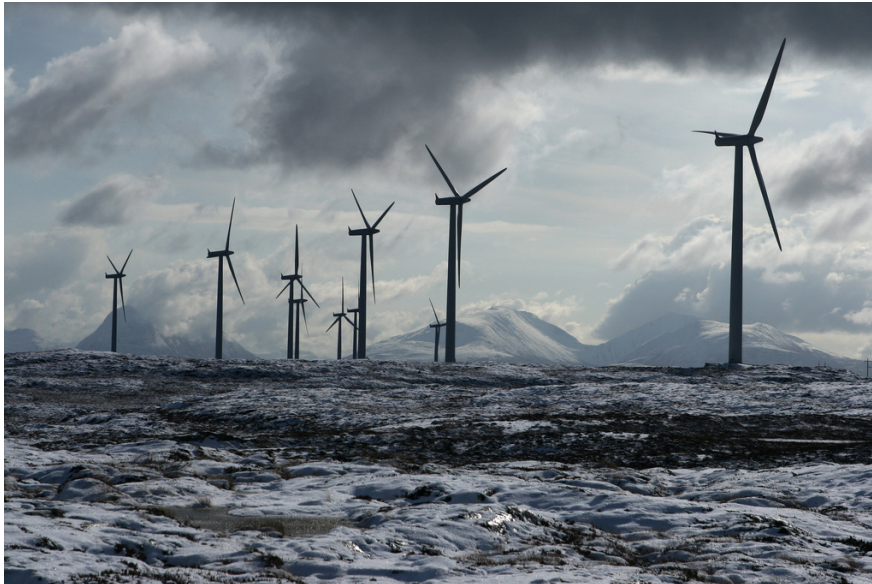
Smøla Wind Farm, uno de los parques eólicos de Statkraft en Noruega.
