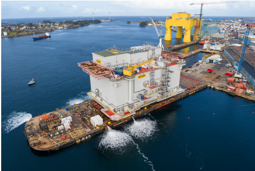
Así fue la odisea de montar la subestación de casi 10.000 toneladas de peso en el mayor parque eólico marino del mundo
