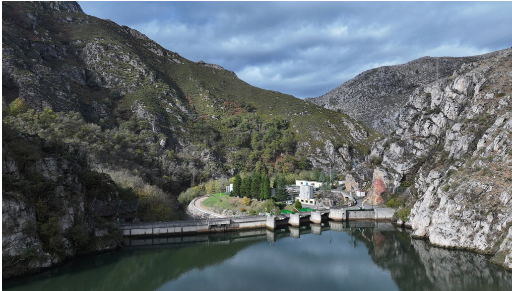
Central hidroeléctrica en Rioseco.
