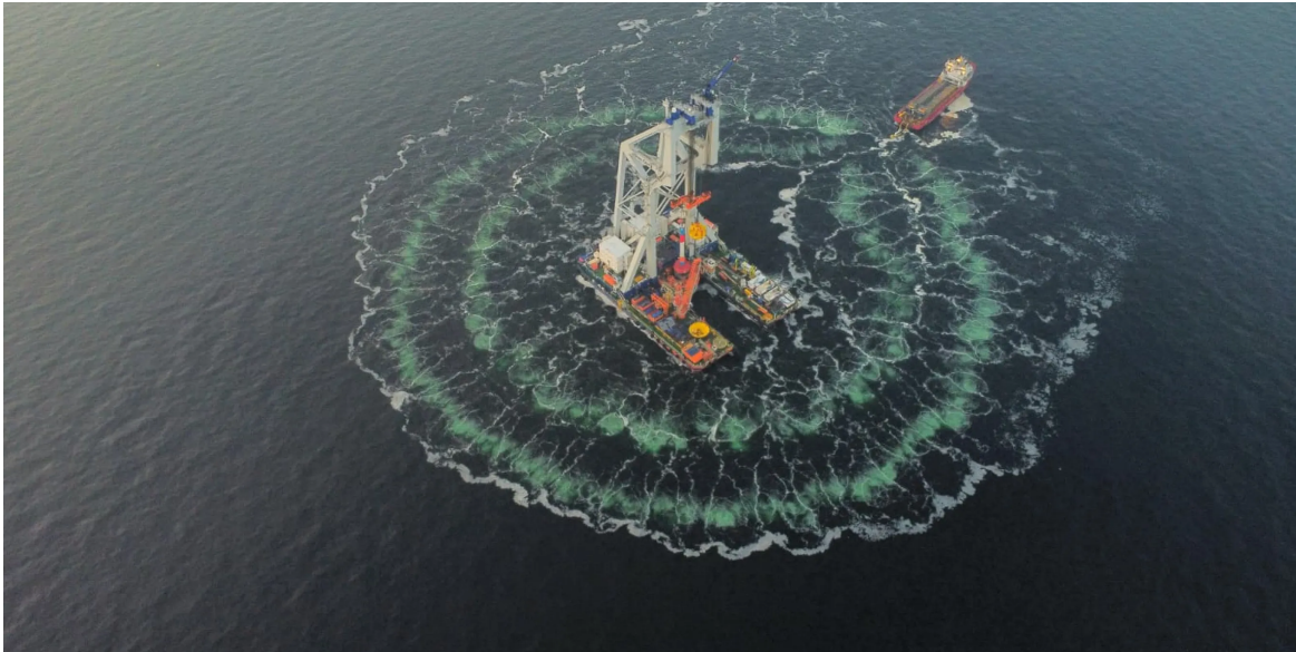
Van Oord completa la instalación de los monopilotes del parque eólico Windanker de Iberdrola en el mar Báltico alemán
