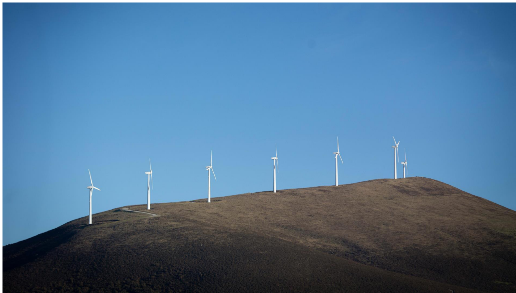
Varios aerogeneradores en el parque eólico de Vilachá, a 15 de marzo de 2024, en Lugo, Galicia (España).
