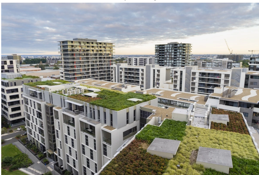
Edificios verdes CICfeb21 123rf1
