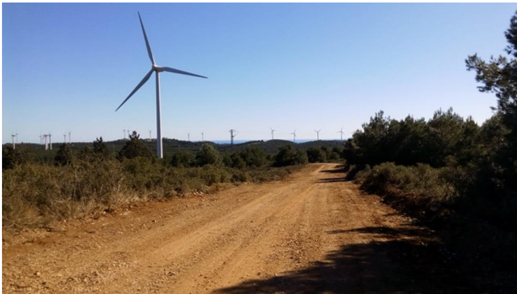
Imatge d'un arxiu d'un parc eòlic a la Collada del Perelló
