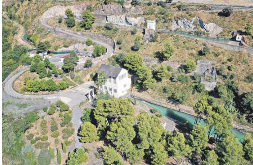
Las centrales hidráulicas están situadas en cascada y aprovechan el mismo caudal de agua.
