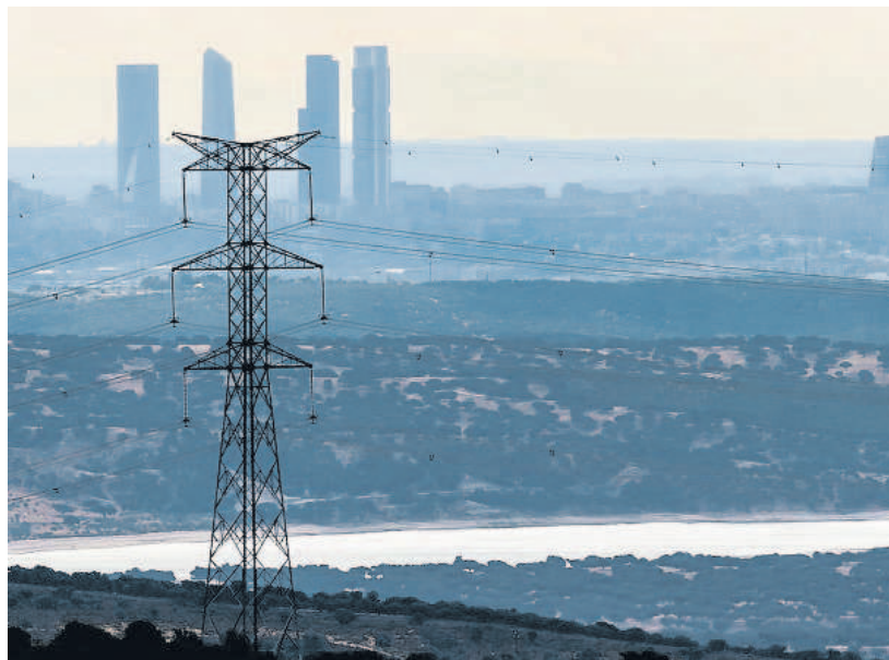
Torre de alta tensión con Madrid de fondo
