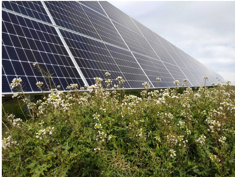
Instalaciones fotovoltaicas de Solaria.
