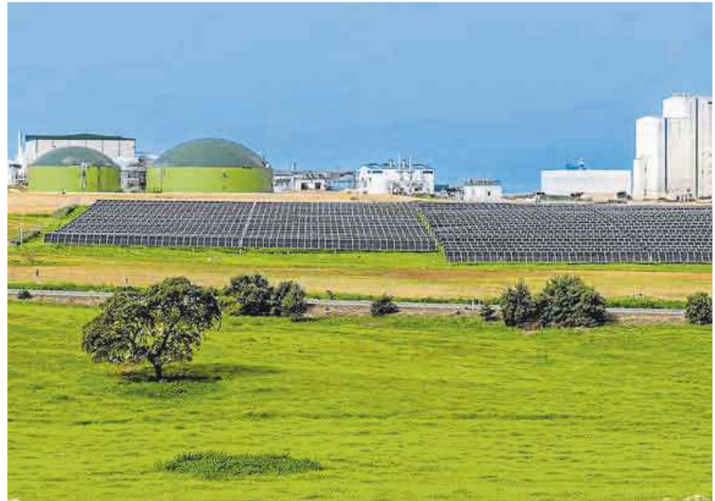
El polo verde de Covap: en primer plano la planta solar; detrás a la izquierda, los generadores de biogás.
