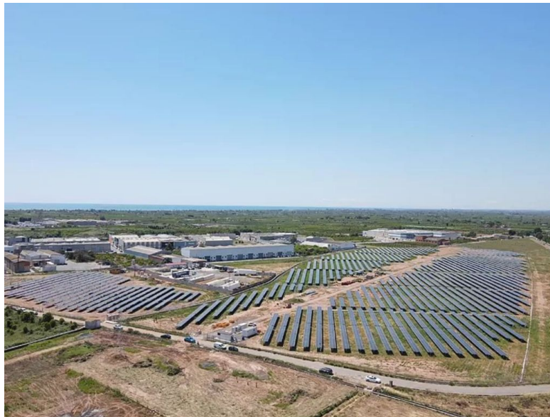
Endurance Motive ejecutará el primer gran proyecto de almacenamiento para hibridación solar en la Comunidad Valenciana.
