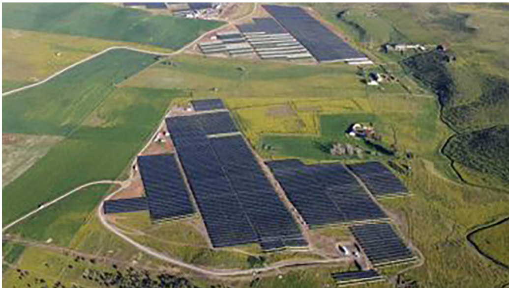
Endesa inaugura su primera planta solar en España hibridada, El Matorral, con sistema de batería de litio.
