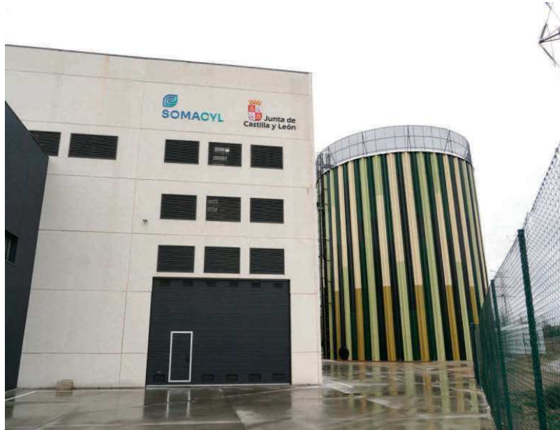
El sistema centralizado de calefacción urbana utiliza biomasa como combustible, mejorando la eficiencia energética. EL MUNDO
