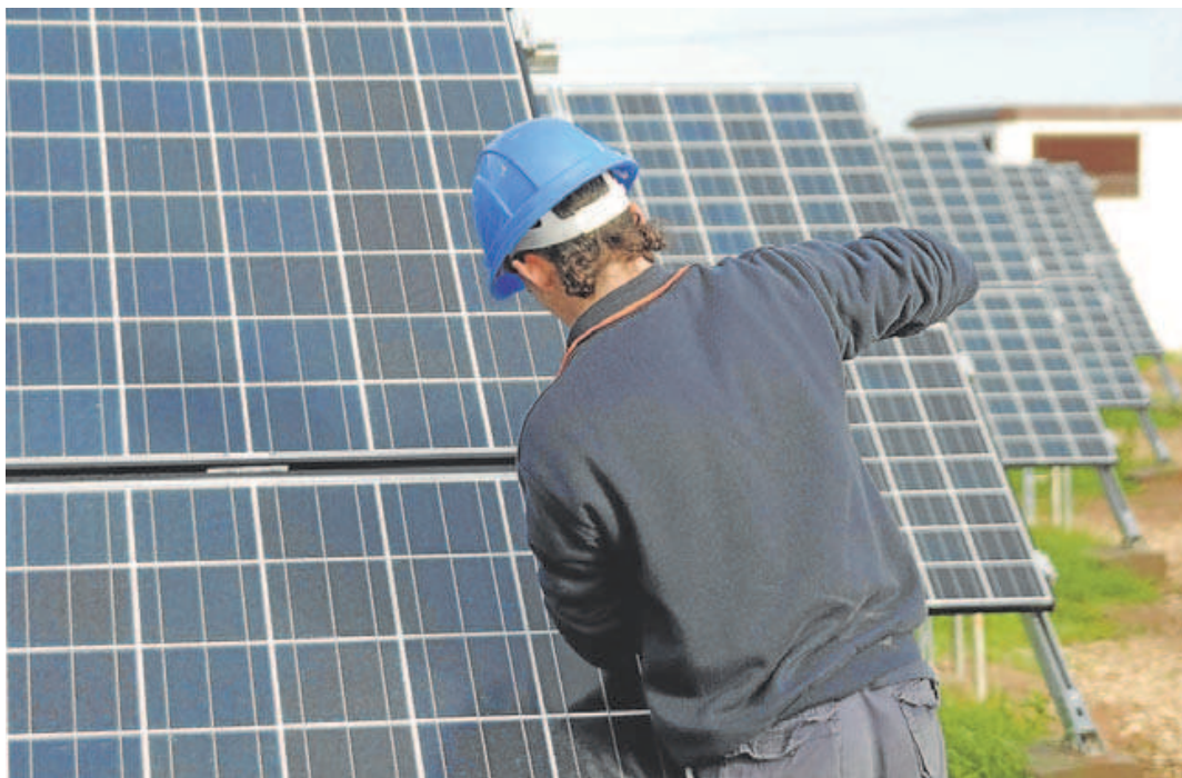
Un operario trabaja en la instalación de una placa fotovoltaica. EL CORREO
