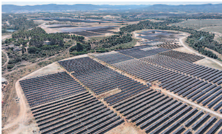
Plantas fotovoltaicas Zorita I y Zorita II
