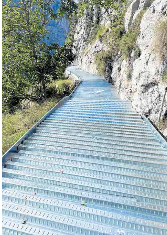
La empresa instaló primero chapas metálicas en el antiguo canal. DM
