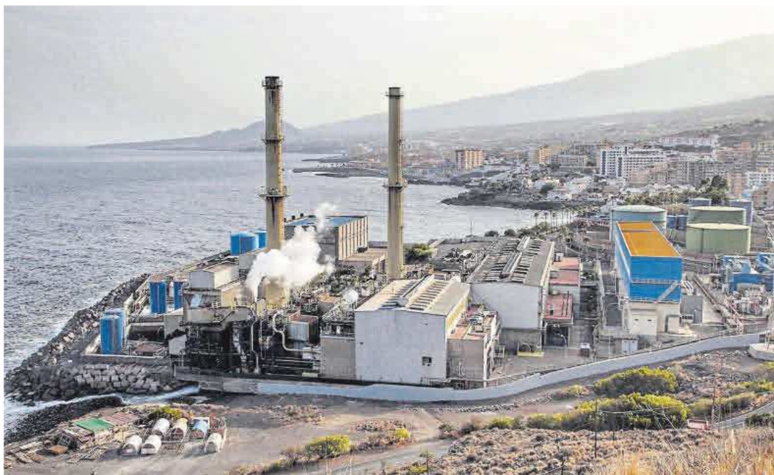
Central térmica de Las Caletillas, en Candelaria, Tenerife.
