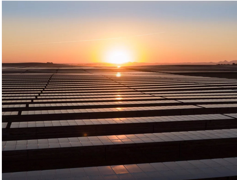
Proyecto solar. FOTO: Encavis
