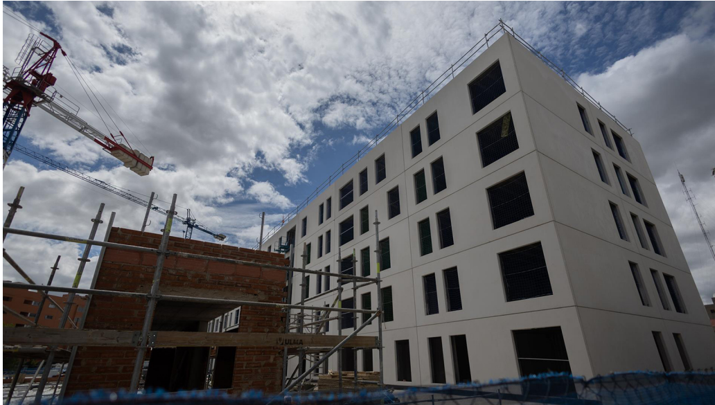
Construcción de un bloque de viviendas.
