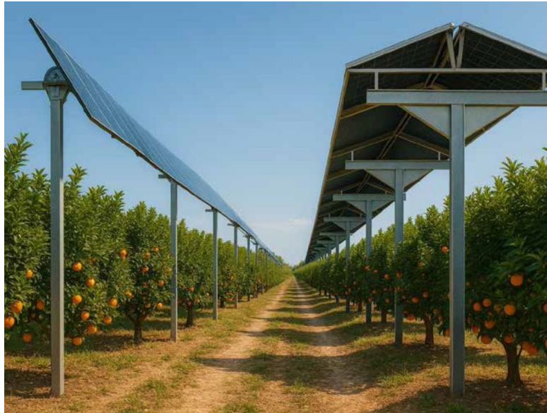
La UPV impulsa la primera planta piloto agrivoltaica sobre cultivo de cítricos para avanzar en agricultura 4.0.
