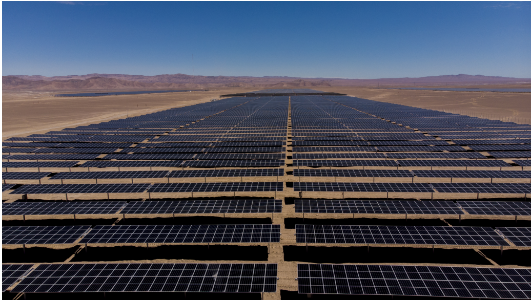
Planta fotovoltaica de Grenergy.
