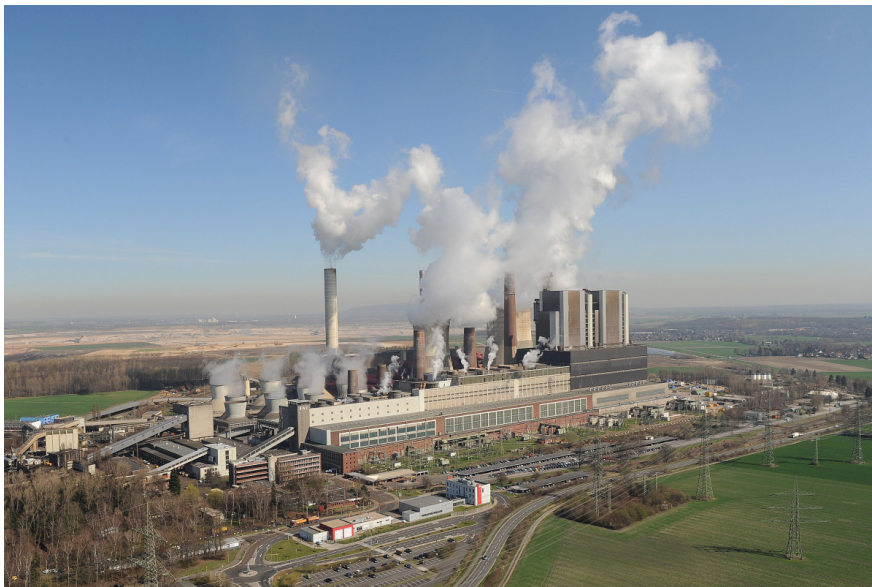
Central eléctrica de carbón de Weisweiler, Alemania.
