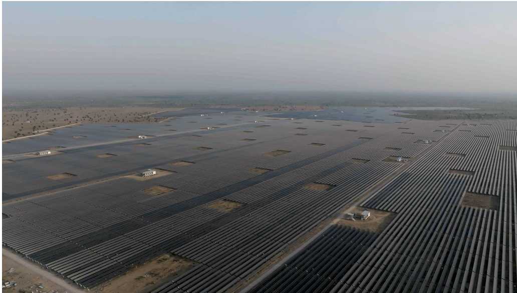
Planta fotovoltaica de Acciona Energía.
