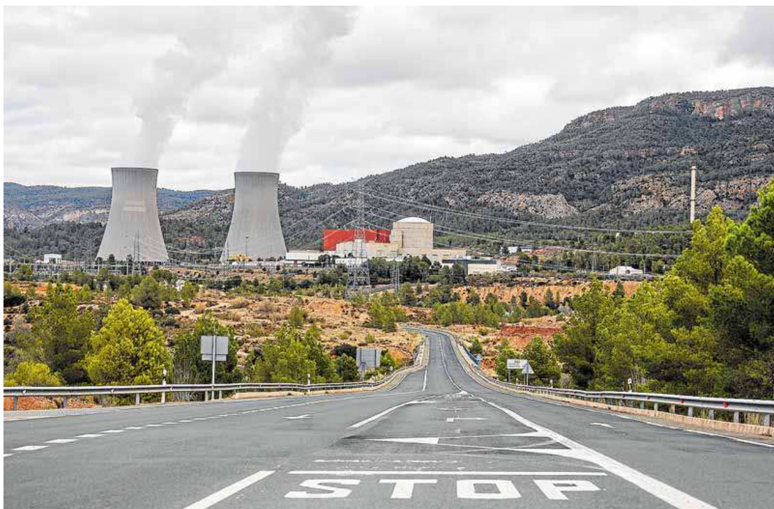
Las dos torres de refrigeración de la central de Cofrentes destacan en el paisaje. ROBER SOLSONA/EP
