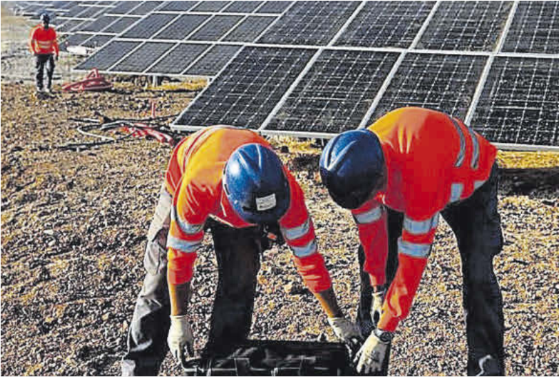
Trabajos de montaje de la planta fotovoltaica Núñez de Balboa entre Usagre e Hinojosa. | 'activos'
