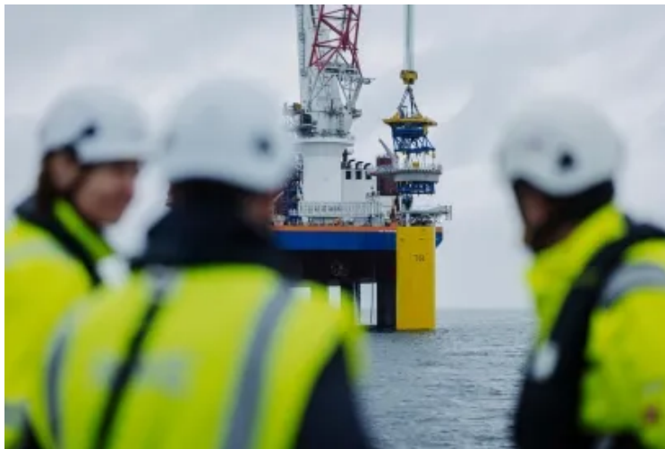
RWE culmina la instalación de los cimientos de Thor, el mayor parque eólico marino de Dinamarca
