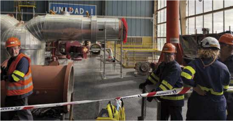
Trabajos de recarga en la Unidad I de la Central Nuclear de Almaraz, en Cáceres. | 'activos'
