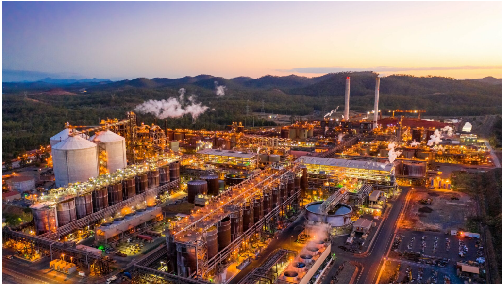
Refinería de alúmina de Yarwun, Australia.
