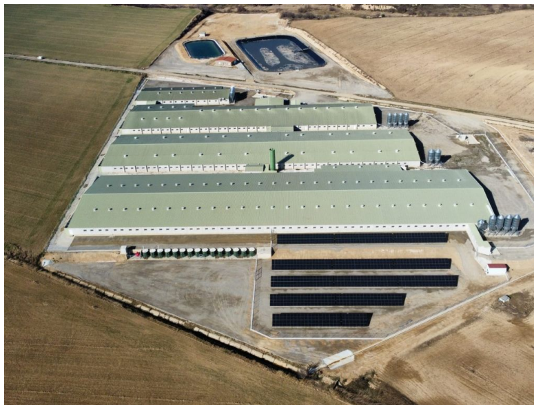
Hibridación diésel-fotovoltaica para núcleo de reproducción porcina.
