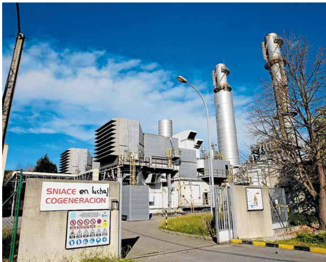
Una planta de cogeneración. LP
